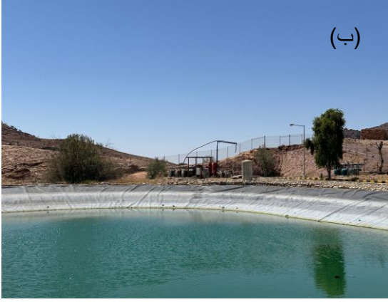
رسم توضيحي 8. (أ) حوض التهوية، (ب) بركة تجميع المخرج بفترة مكوث ١٠ أيام، (ج) عينة مخرج مقابل عينة مدخل، (د) أحواض تجفيف الحمأة
