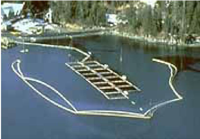
هي حواجز عائمة مصنعة من المطاط والمعادن وبعض المواد الأخرى يتم وضعها لمحاصرة بقع الزيت ومنعها من الانتشار إلى مناطق أخرى ويراعى في تصميمها أن لا تسمح بمرور الزيت من تحتها. تستخدم هذه المصدات العائمة في عمليات حماية بعض المناطق الحساسة في عمق المياه (Open Water Boom) وعلى السواحل (Shallow Water Booms) واليابسة (Inland Boom) وحواجز الموانئ (Harbour Boom).
